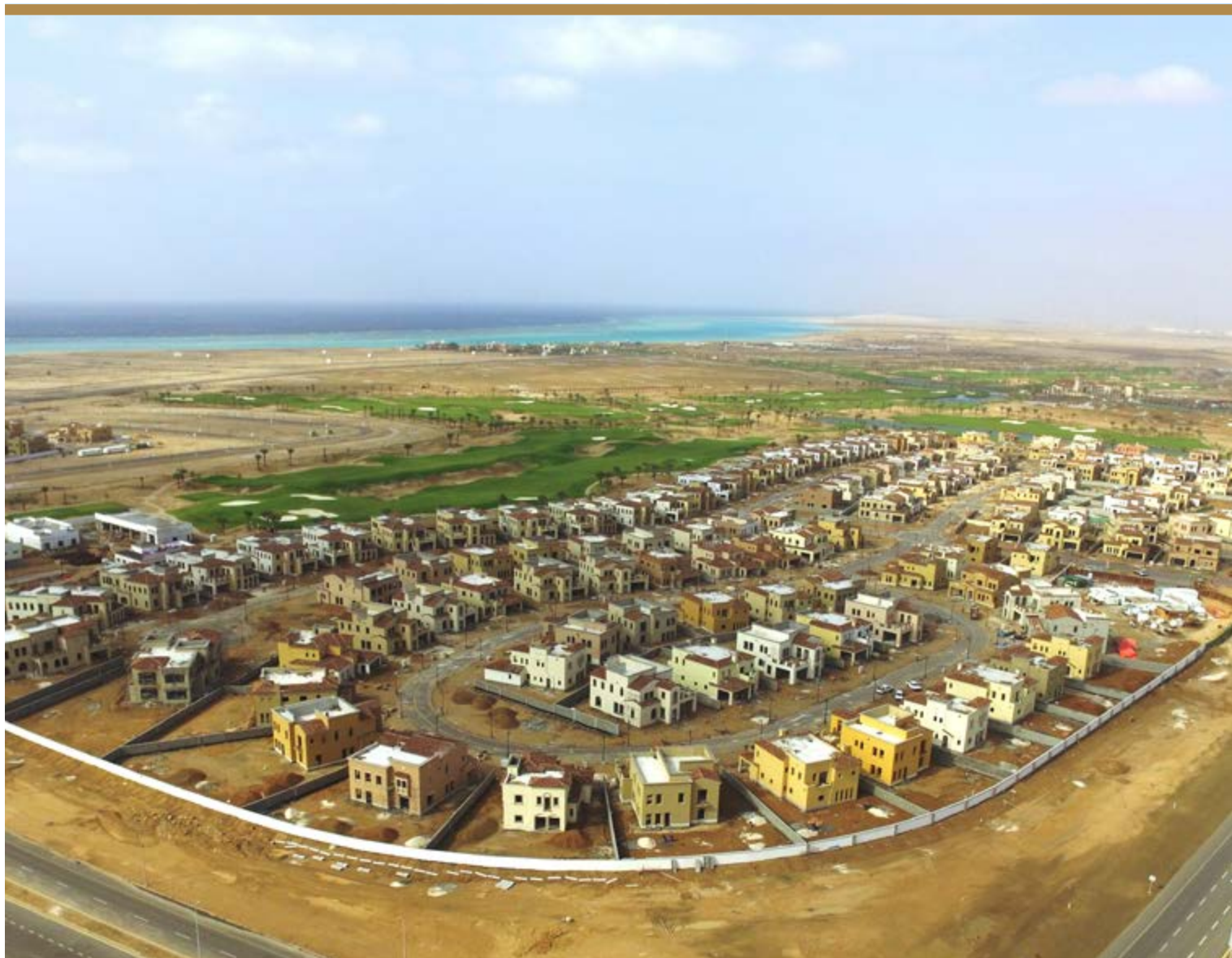
فلل حي المروج المطلة على ملعب الغولف "تحت الانشاء والتطوير"
